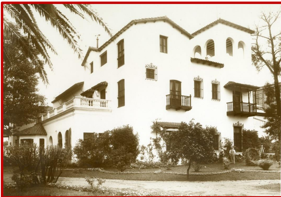
El "Chalet" del Ingenio Bella Vista. Se incendió en 1929. Fue reconstruido según proyecto del Arq. José Graña en 1930
