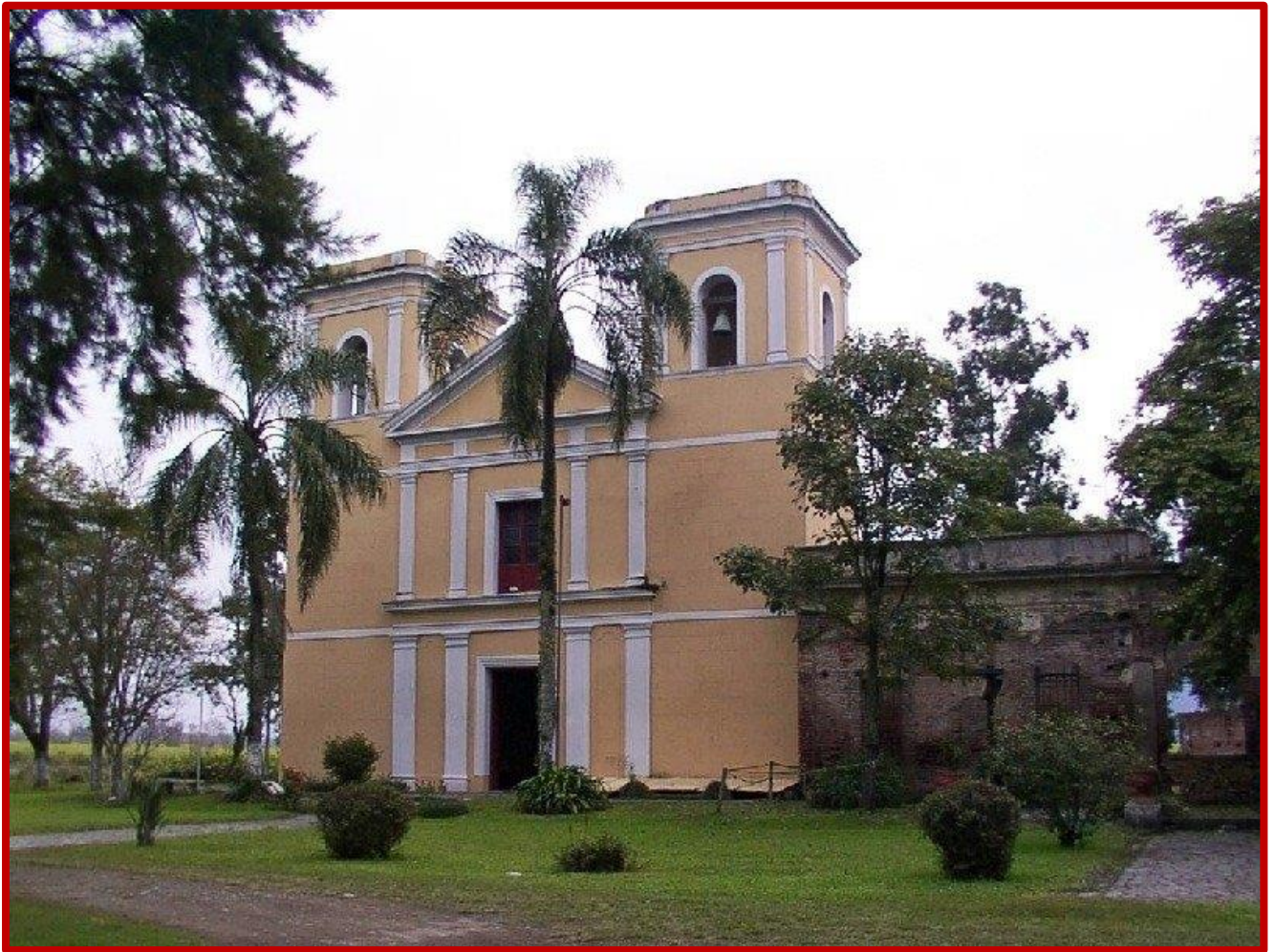
Reducción jesuita de los Lules. En la imagen la iglesia que se construyó en S. XIX
