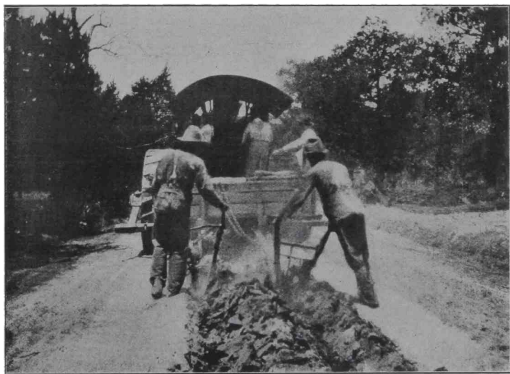
Mezclando arena y barro en un camino de piso natural — Uno de dichos arados tiene la manera a la derecha y el otro a la izquierda, tirado por una máquina de tracción.
